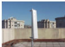
En una antena típica de telefonía móvil como la que aparece en la figura adjunta, la emisión radioeléctrica se efectúa hacia el frente y en horizontal, en forma de un haz sensiblemente plano, y abarca un sector entre 60 y 120 grados. Las emisiones son casi inexistentes en el resto de direcciones (atrás, abajo y arriba).
